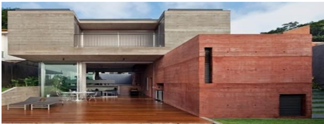
Figura 2: Edificação em concreto colorido
