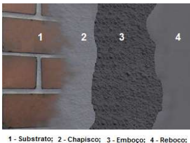
Figura 2 – Argamassa de revestimento em diferentes camadas. Fonte: Adaptado de BENEVENTI, 2013
