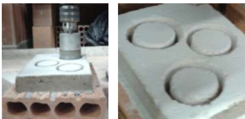
Figura 11 – Furos sobre o revestimento Fonte: Elaboradas pelos autores
