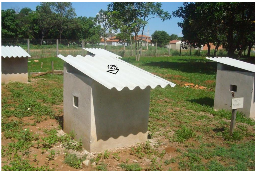
Figura 15 - Unidades prontas para aplicação do revestimento proposto
