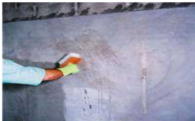
Figura 2: Umedecimento da parede com utilização de trincha
