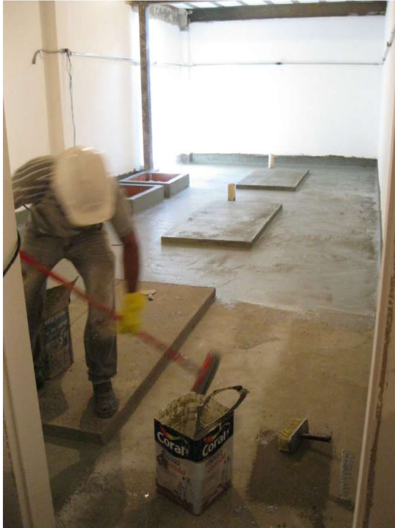
Figura 5: aplicação de cimento polimérico em casa de máquinas
