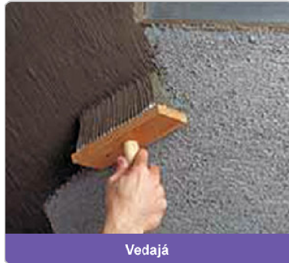
Figura 3: Aplicação com broxa ou trincha de 2 a 4 mãos cruzadas de argamassa impermeável, no intervalo de 6 horas.
