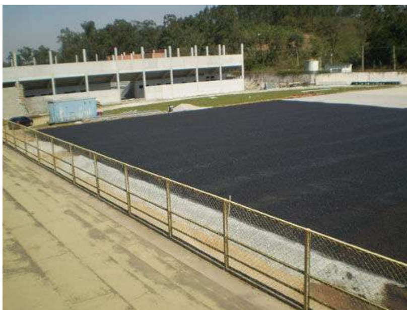
Figura 6: emulsão asfáltica aplicada sobre base
