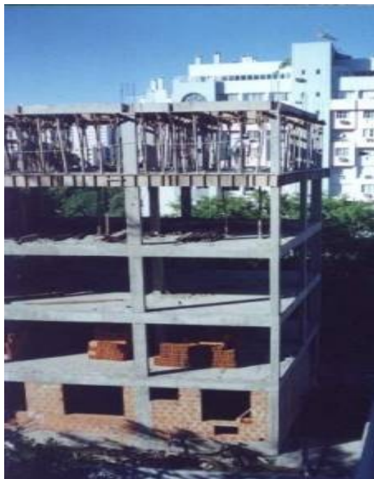
Figura 07: Estrutura Reticulada
