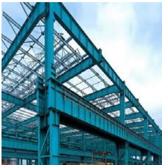
Figura 10: Estrutura de Aço
