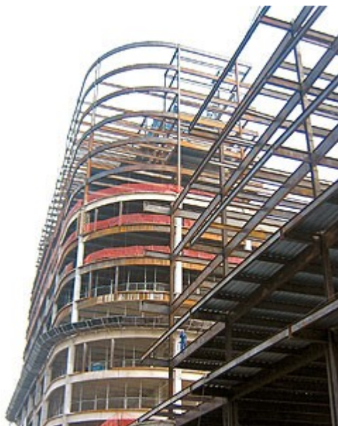
Figura 09: Estrutura de Aço
