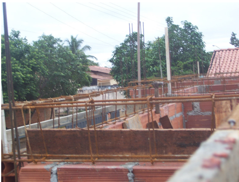
Figura 18: Armação de Viga Sobre Alvenaria
