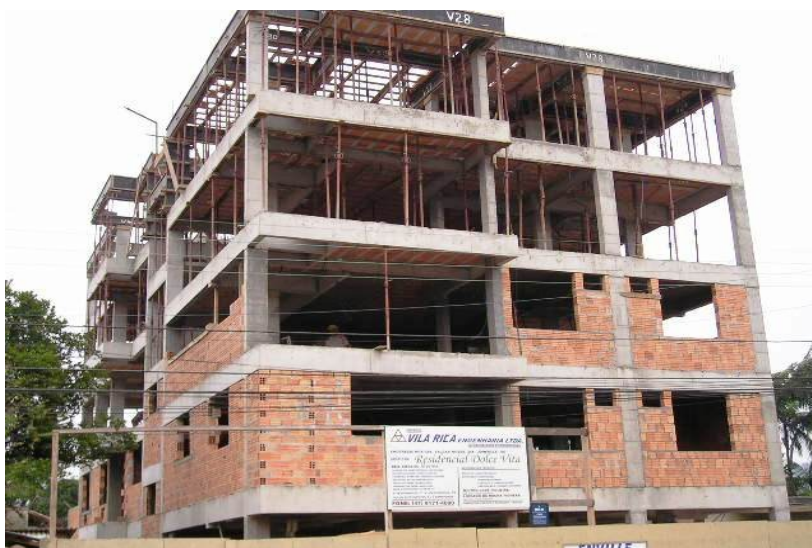
Figura 08: Estrutura Reticulada
