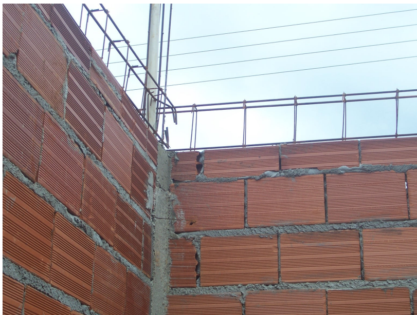
Figura 19: Armação de Viga Sobre Alvenaria - Obra Pequena
