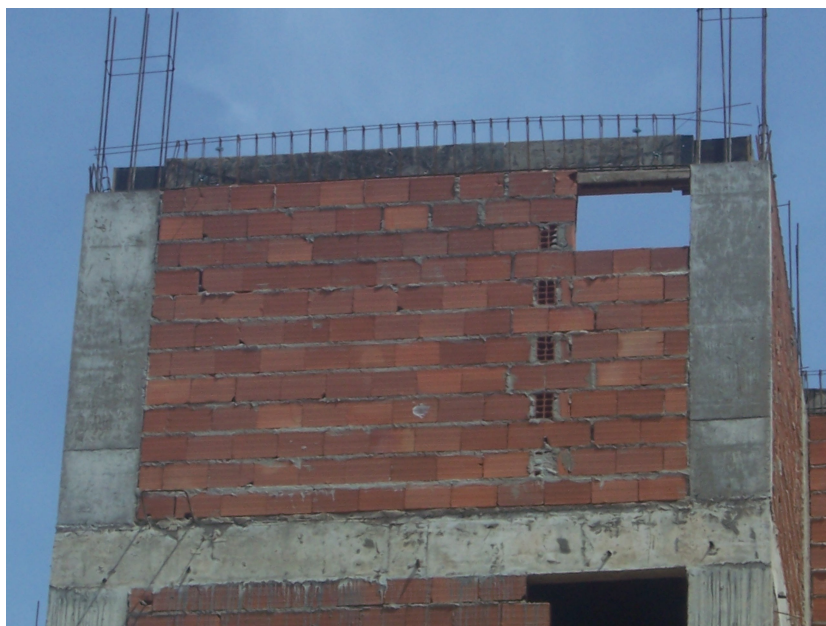
Figura 21: Má Concepção Estrutural
