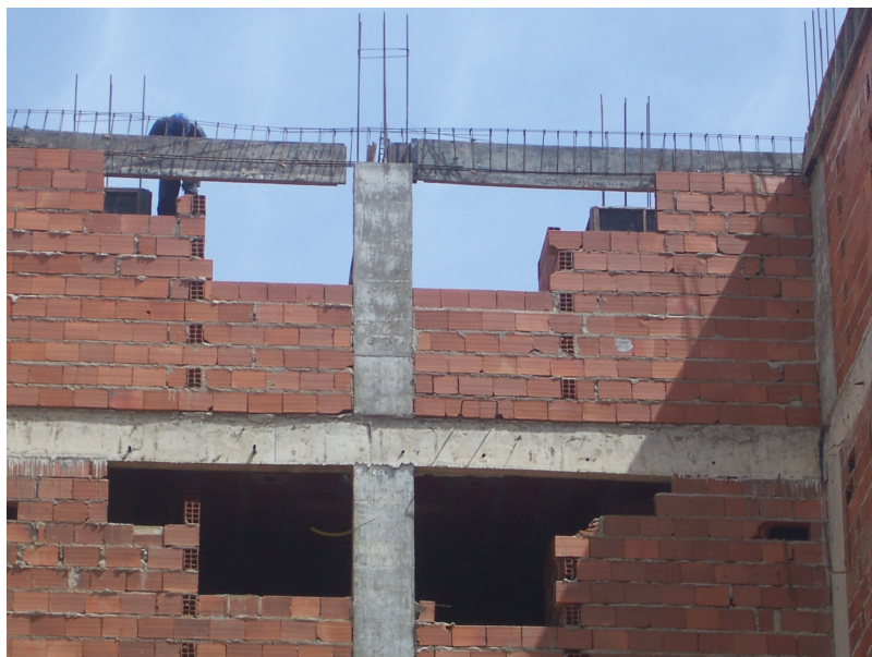
Figura 20: Armação de Viga Sobre Alvenaria - Obra Grande
