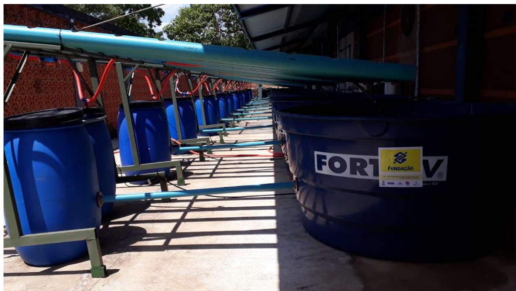
Figura 4 - Sistema de recirculação de água
