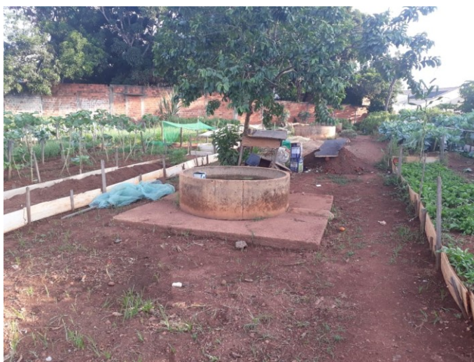
Figura 26 - Tanque reservatório de água da Horta Comunitária da 605 Norte.
