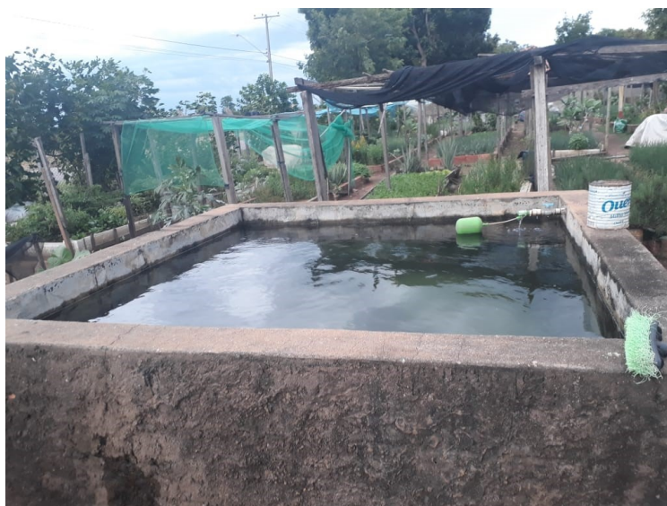
Figura 22 - Tanque reservatório de água da Horta Comunitária da 407 Norte.
