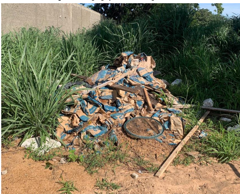
Figura 12 -Segregação de embalagens de cimento
