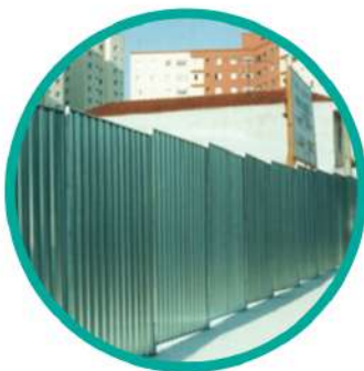
TAPUME DE METÁLICO
