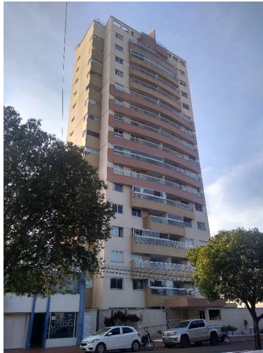
Figura 13 – Fachada do edifício
