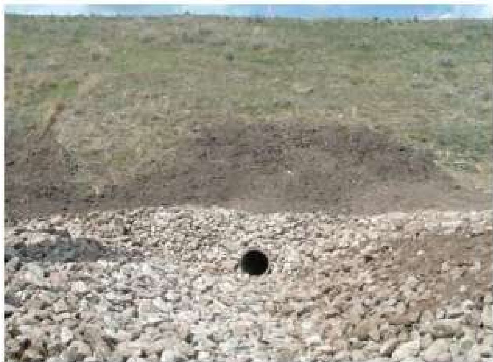
Figura 30 – Tapete de enrocamento à saída de uma passagem hidráulica
