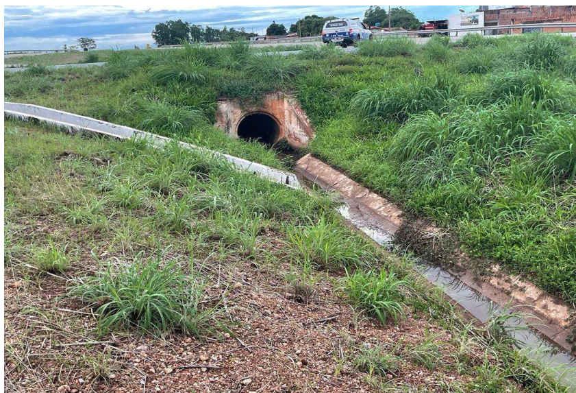
Figura 27 – Bueiro e Canaleta que escoam a água proveniente da Br – 242
