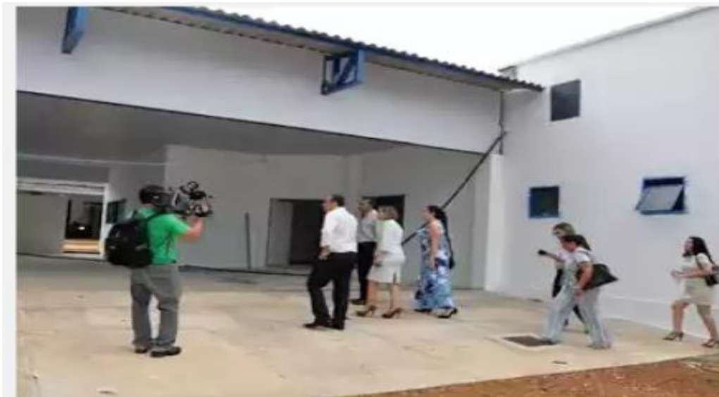
Secretária de Saúde, Vanda Paiva, em visita às obras de ampliação do Hospital Regional de Porto Nacional
