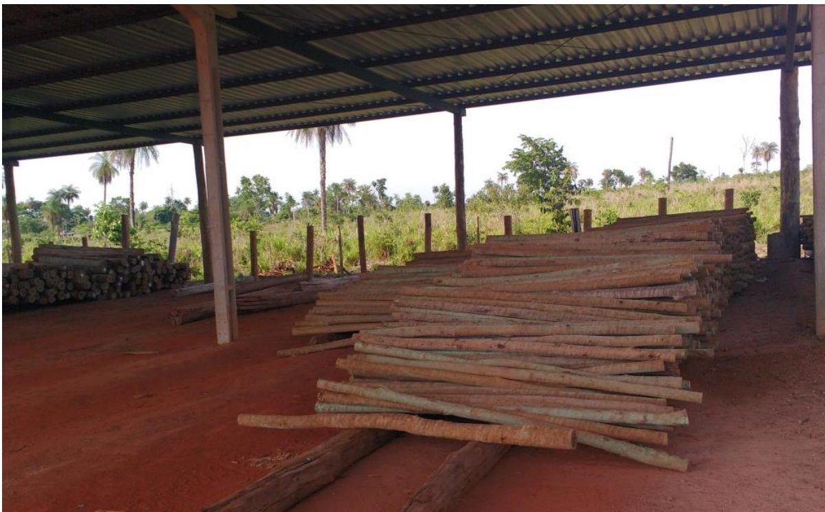
Figura 1. Galpão para armazenamento de madeira tratada.
