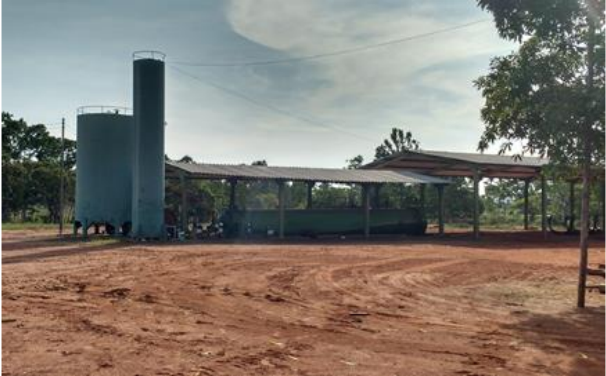
Figura 2. Galpão com a autoclave e reservatórios de água e da solução de tratamento.
